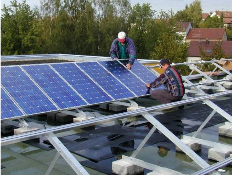
Figura 3 Los perfiles de aluminio de Schletter se usan para el montaje de instalaciones solares.
