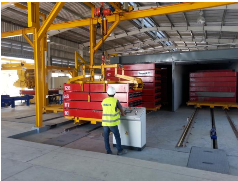
Fig. 8: Специальная подъемная траверса на выходе из камеры выдержки транспортирует формы на станцию обжатия
