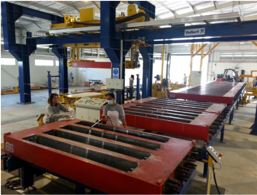
Fig. 1: Primeiro os moldes de quatro dormentes são oleados e limpos após o processo de desmoldagem, antes de as buchas para a fixação posterior dos trilhos serem introduzidas.
