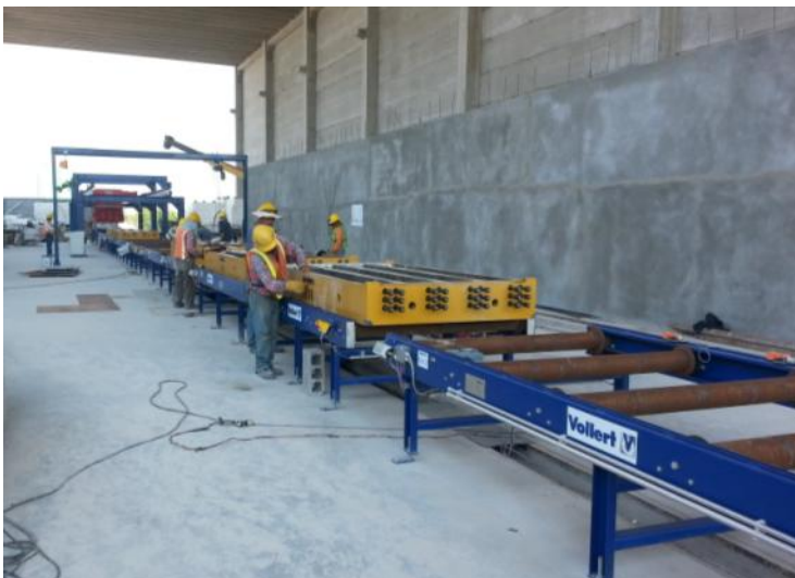
Fig. 3: Рольганг доставляет подготовленную форму в звуконепроницаемую камеру для бетонирования
