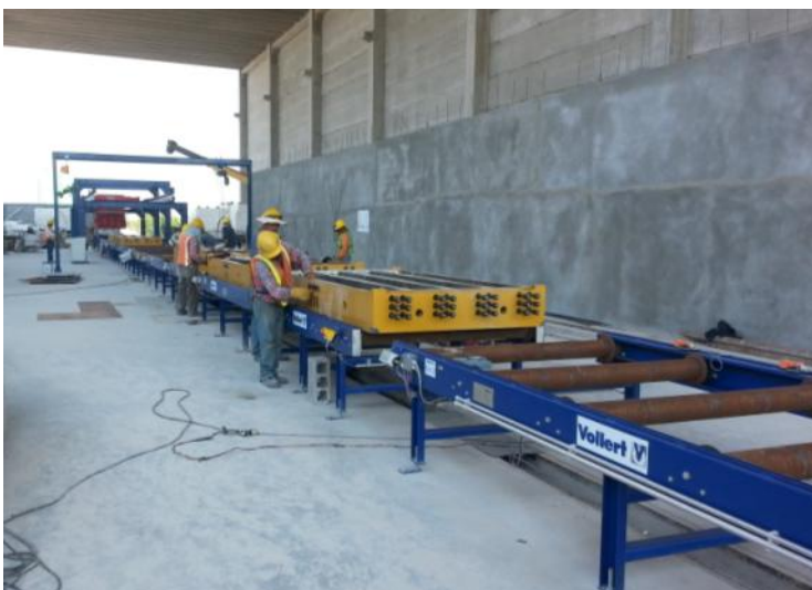
Fig. 3: El transportador de rodillos traslada el molde premontado a la cámara de hormigonado insonorizada.
