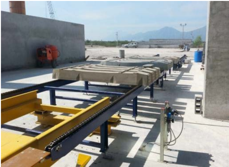
Fig. 5: Los durmientes de concreto pretensados salen de planta listos para ser instalados.
