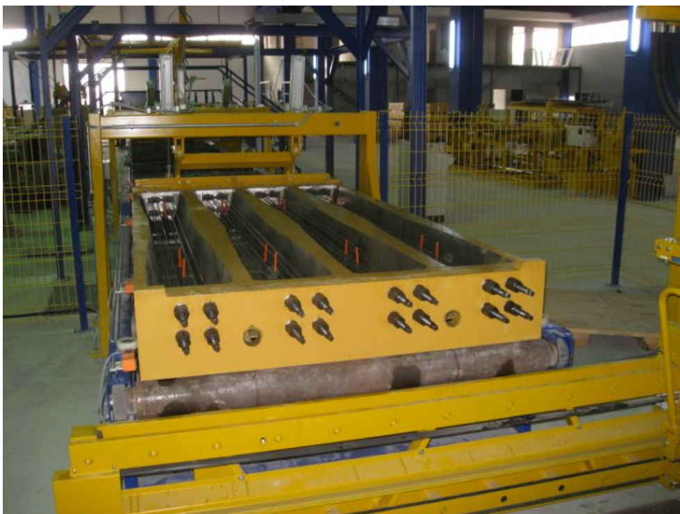
Fig 2: Форма для шпал после закладки арматуры
