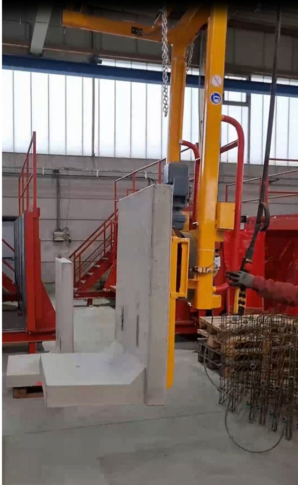
Photo 7 : Une traverse de levage à vide guidée par grue est idéale pour retirer en toute sécurité les briques angulaires en L du moule de coffrage après le décoffrage.
