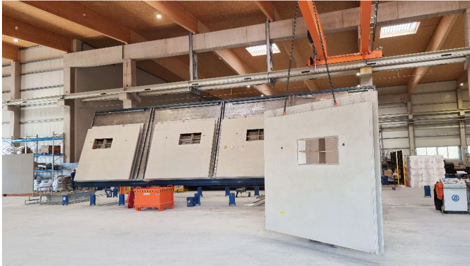
Photo 9 : Une station de basculement VARIO TILT effectue le soulèvement vertical des prémurs.
