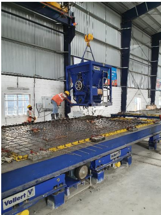
Figura 6 Después del posicionamiento manual de los perfiles de encofrado y las rejillas de refuerzo mediante una cuba dosificadora de hormigón guiado por una grúa y accionada eléctricamente se aplica la cantidad necesaria exacta de hormigón requerida.
