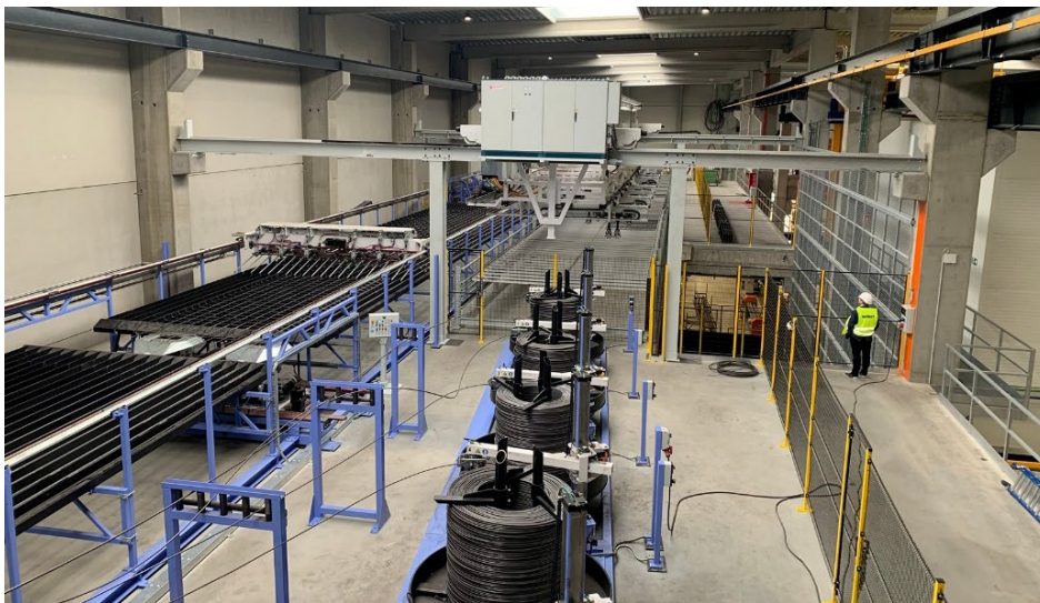
Figura 7 + 8 Toda a preparação totalmente automatizada da armação ocorre em um mezanino intermediário.
