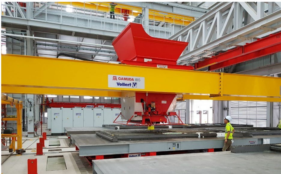
Figura 4 Un intercambio de señales en línea entre el distribuidor de hormigón y el transportador de cubas con posiciones de transferencia variables, especificado en los planes, garantiza un recorrido corto del cortas del distribuidor de hormigón hacia la transferencia de hormigón.
