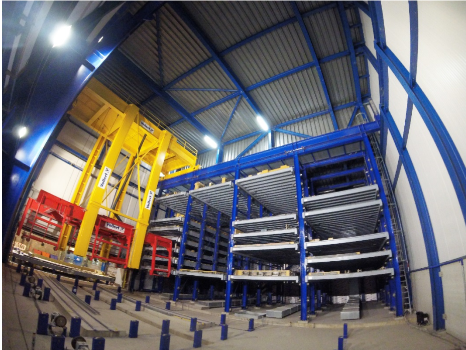
Figura 5 Uma máquina de recolhimento VARIO STORE alimenta as torres de estantes da câmara de cura.
