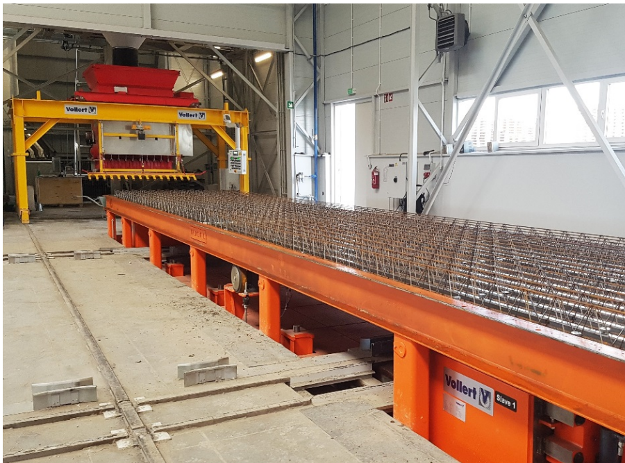
Figura 4 Um distribuidor de concreto SMART CAST aplica o concreto fresco, e parafusos de descarga controlados individualmente, preenchem cada câmara de forma otimizada.
