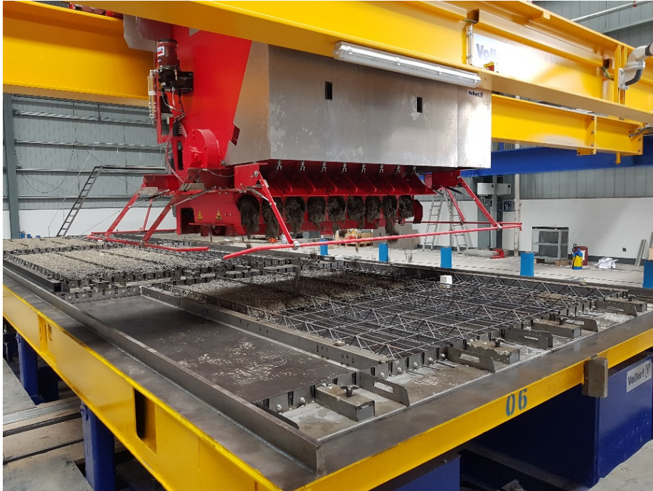
Figura 5 Aplicação precisa do concreto através de um distribuidor de concreto automático SMART CAST.
