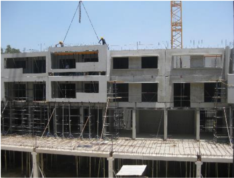
Fig. 3: El proyecto del gobierno «Housing for all by 2022» (Viviendas para todos hasta 2022) requiere espacio habitable asequible de rápida construcción.
