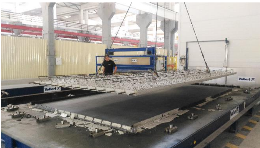
Рис. 8: Первые сборные элементы перекрытий для новых строительных проектов в сердце Ташкента производятся с октября 2016 года
