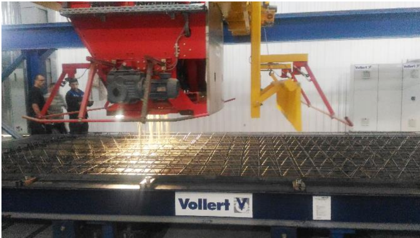
Fig. 4: O volume de descarga e a velocidade do rolo de espigões do distribuidor de concreto são ajustados de forma otimizada às diferentes consistências de concreto
