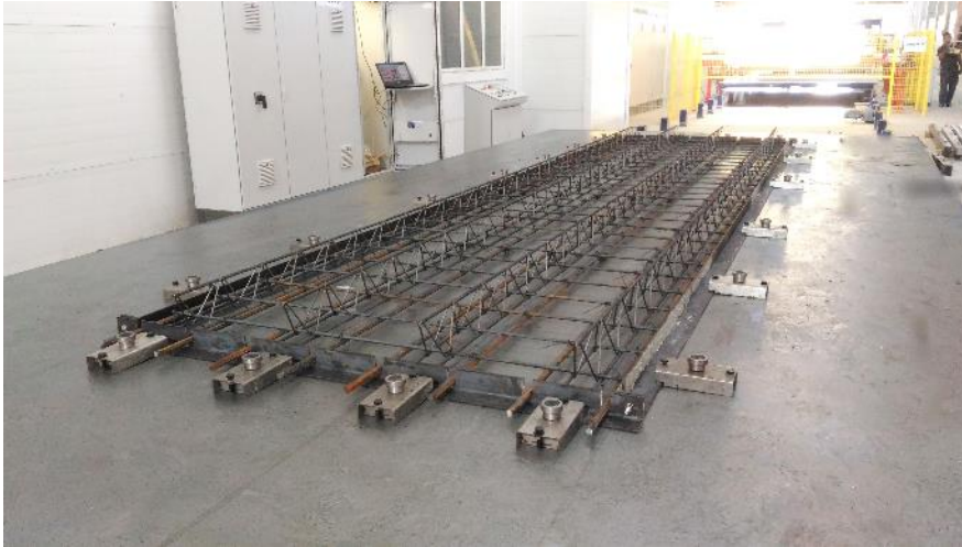
Fig. 3: Uma plotadora de grandes dimensões Smart Plot, controlada por CAD/CAM desenha os contornos a uma escala 1:1, antes de o sistema de desmoldagem e a armadura serem aplicados
