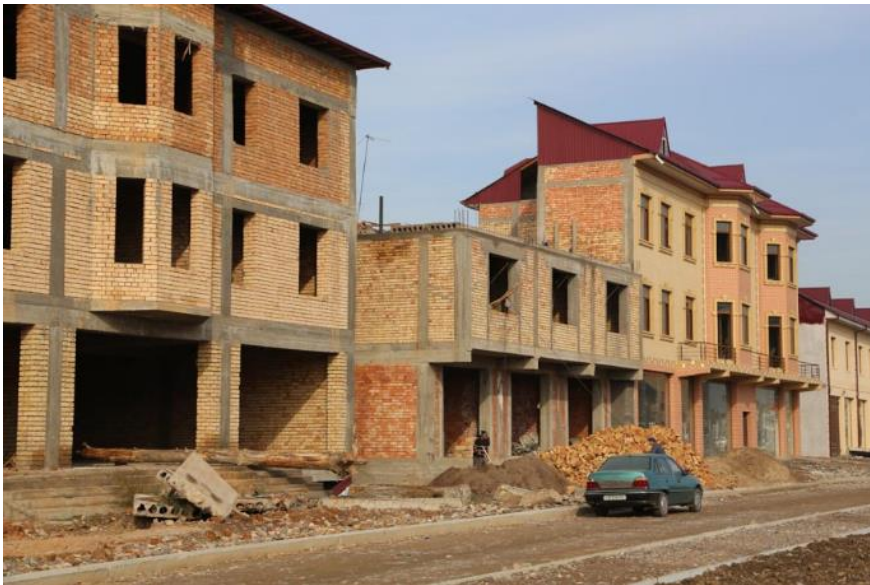
Fig.1: En Uzbekistán, los edificios residenciales tradicionales se siguen construyendo actualmente principalmente de ladrillos
