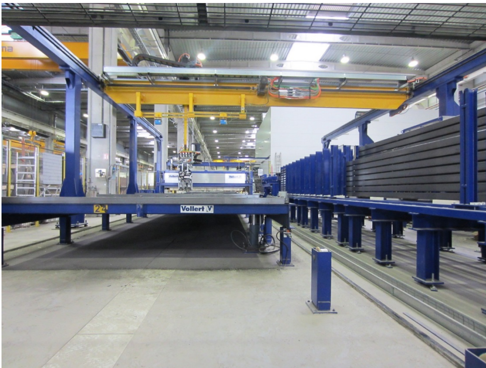
Fig.2: Un robot de encofrado SMART SET 2 coloca los perfiles del encofrado Ratec en la bandeja preparada con precisión y elevada velocidad de desplazamiento
