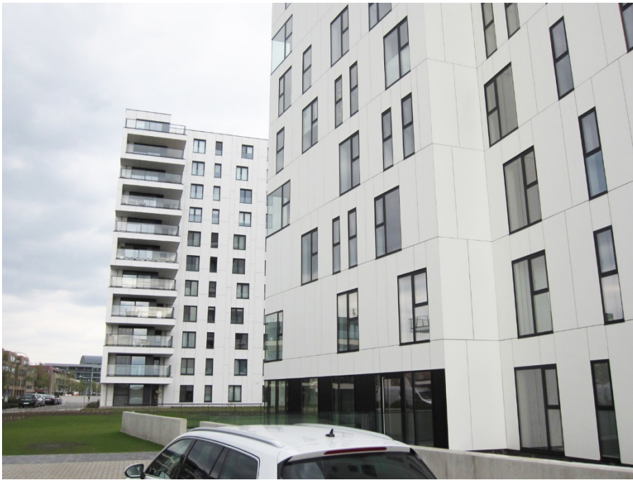
Fig. 9: La arquitectura moderna y atractiva es una característica especial de todos los proyectos del grupo Cordeel
