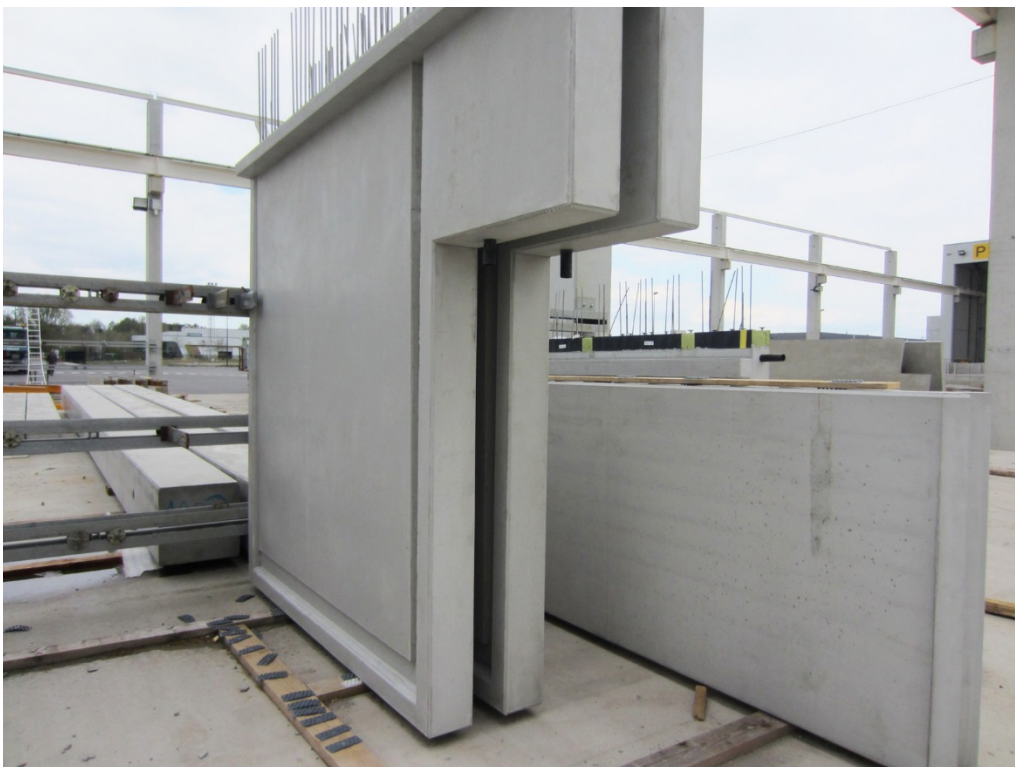
Abb. 8: Für die moderne Architektur in Fertigteilbauweise setzt Cordeel auf vorgefertigte Massiv-, Doppel- und Sandwichbetonteile
