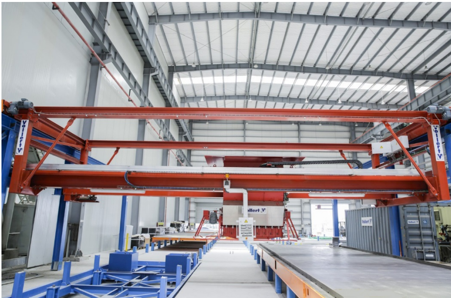
Fig. 3: Introducción precisa del hormigón a través de un modern distribuidor de hormigón automático Smart Cast
