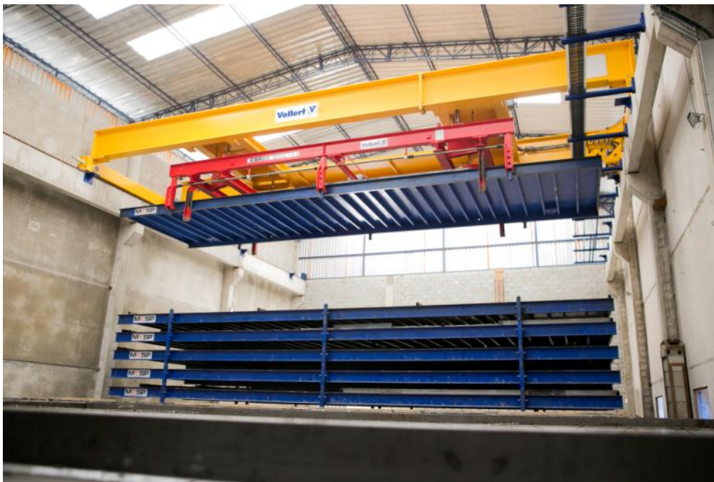
Abb. 4: El moderno proceso de curado permitió disminuir notoriamente los tiempos de ejecución entre el vertido del hormigón y el desencofrado de los elementos
