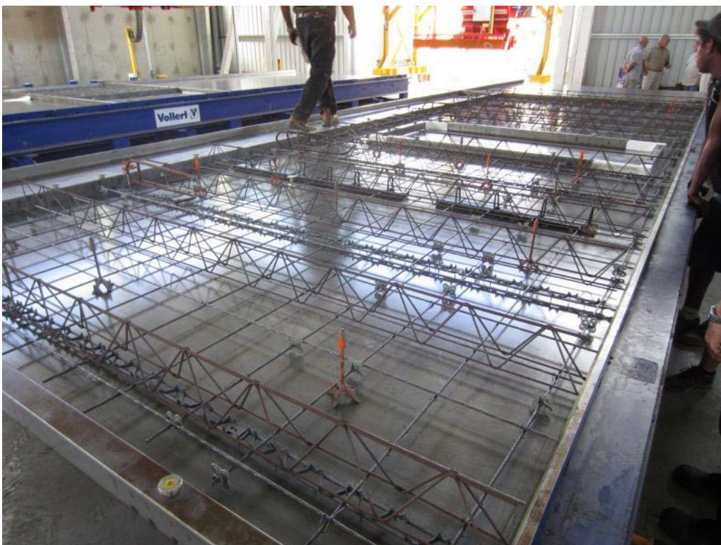
Fig. 4: Укладка арматуры, бетонирование и уплотнение на сверхсовременном оборудовании
