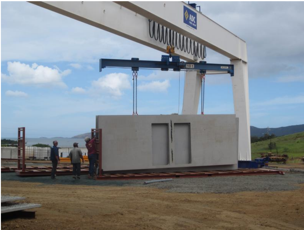
Fig. 9: Завод ЖБИ, запущенный в апреле 2014 г., рассчитан на выпуск элементных перекрытий и сэндвич-панелей, а также балок и опор для цеховых построек
