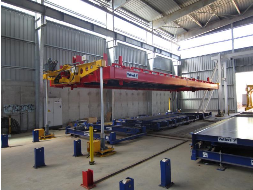
Fig. 7: Producción de muros dobles con equipos de volteo de bandejas estacionarios
