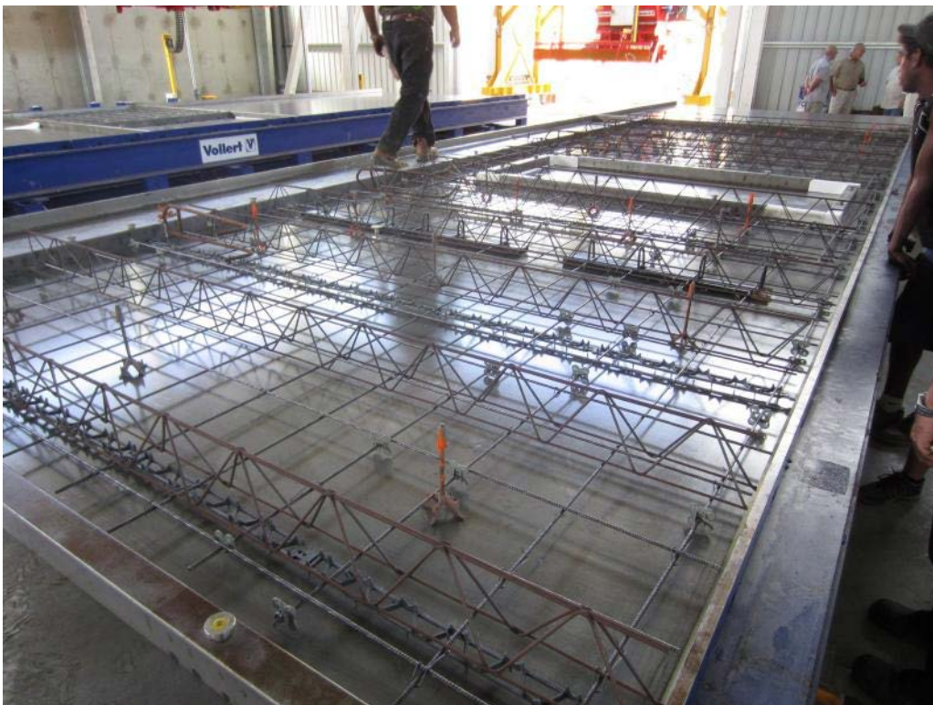
Fig. 4: Armado, hormigonado y compactación con las técnicas de instalaciones más modernas
