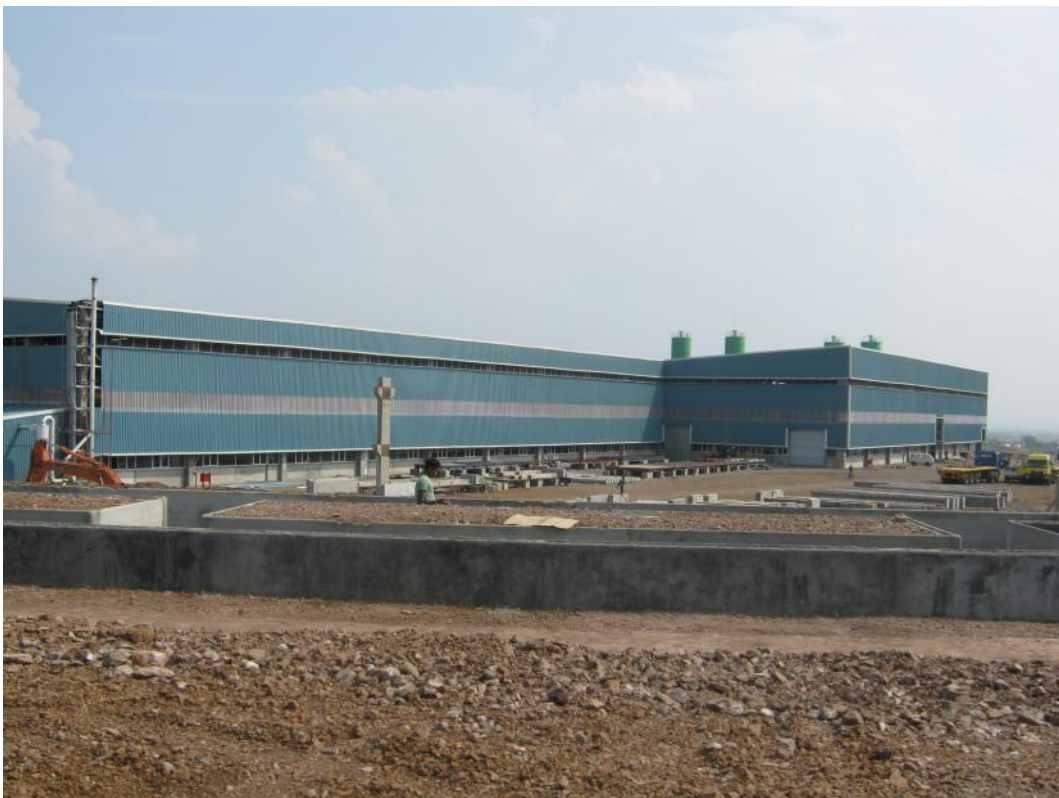
Fig. 18: Площадь нового завода составляет 170 x 25 м
