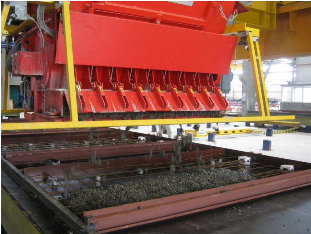
Fig. 8: Заполнение поддона свежим бетоном
