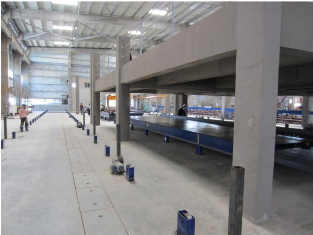
Fig. 10: Параллельные производственные установки обеспечивают гибкость процесса
