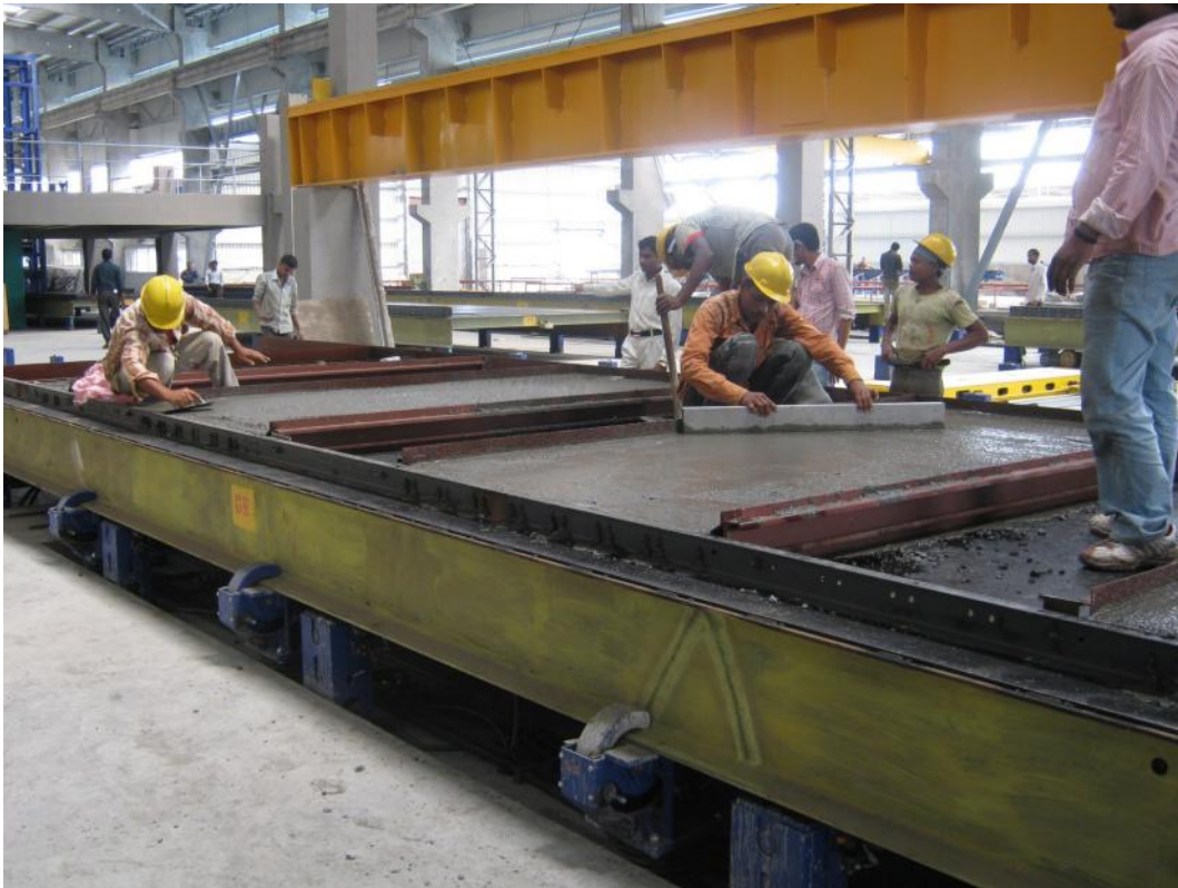
Fig. 15: Ручная затирка бетонной поверхности
