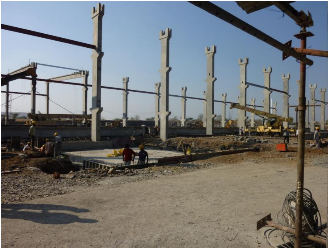
Fig. 3: A construção da nova instalação de produção
