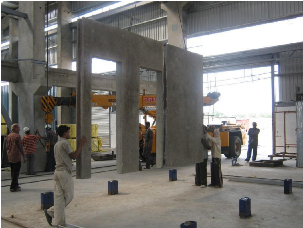
Fig. 17: En el futuro, en la nueva planta de producción se fabricarán 120 m 2 de prefabricados de hormigón a la hora
