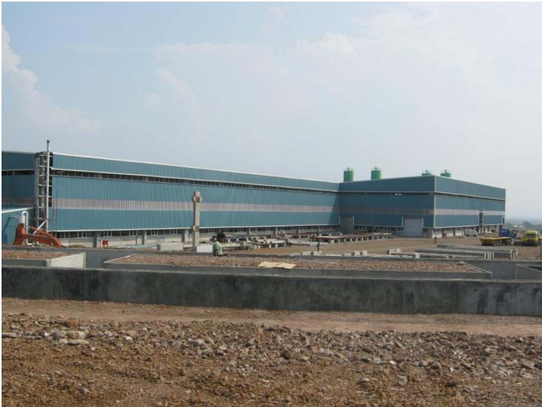
Fig. 18: La nueva planta de producción ocupa una nave con una superficie de 170 x 25 m
