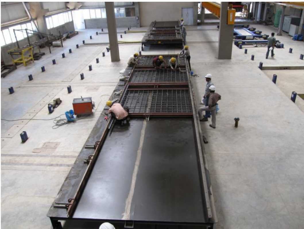
Fig. 6: Colocación de la armadura
